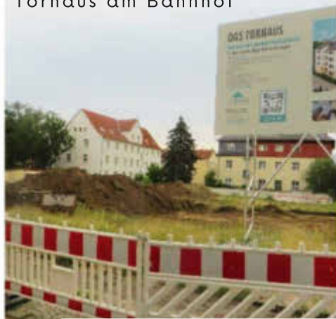
Erdarbeiten für das neue Torhaus am Bahnhof
