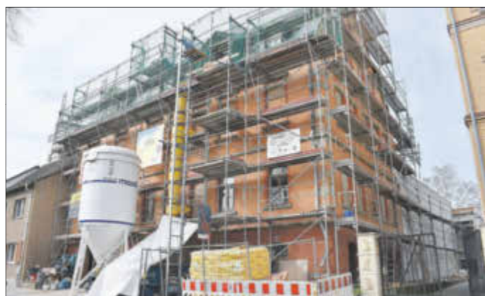
In der Lindenstraße 6 werden umfangreiche Sanierungsarbeiten vorgenommen.
