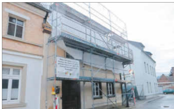
Am Ottomarsplatz finden Sanierungsarbeiten statt.
