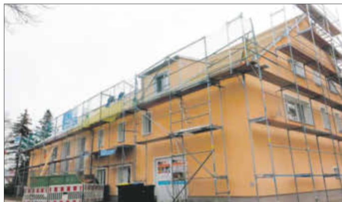
Der Dachstuhl des Tanzsportzentrums wurde teilweise instandgesetzt bzw. erneuert, und das Dach komplett neu eingedeckt.
