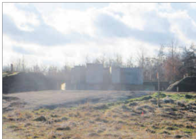
Die Arbeiten am Aussichtspunkt ruhen zur Zeit.
