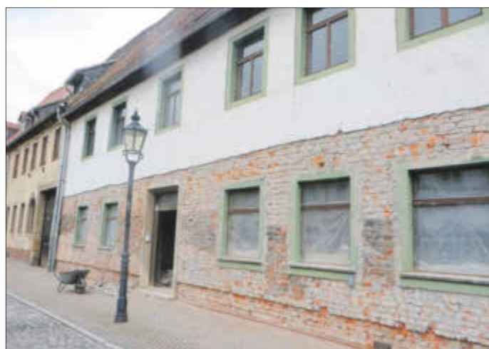
Breitstraße 24: Vorbereitung der Sanierung der Fassade.
