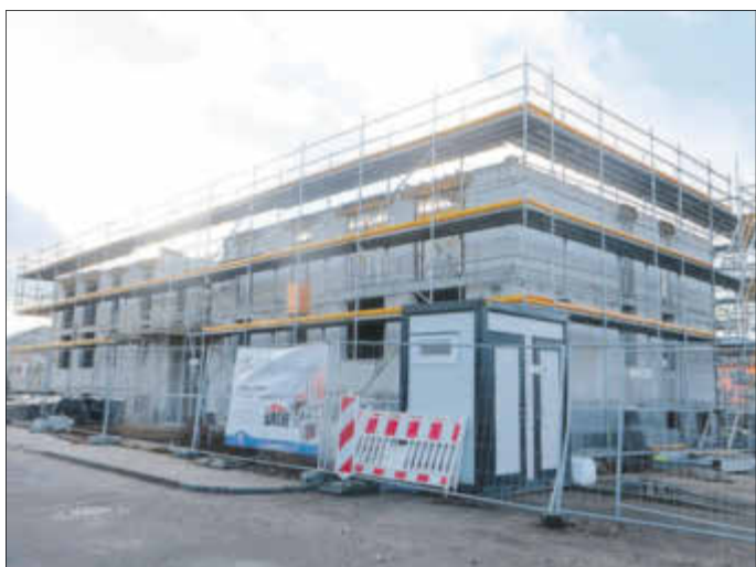
Schloßfabrik: Errichtung zweier Mehrfamilienhäuser (hier die Rohbauten) für die WBG Böhlen.
