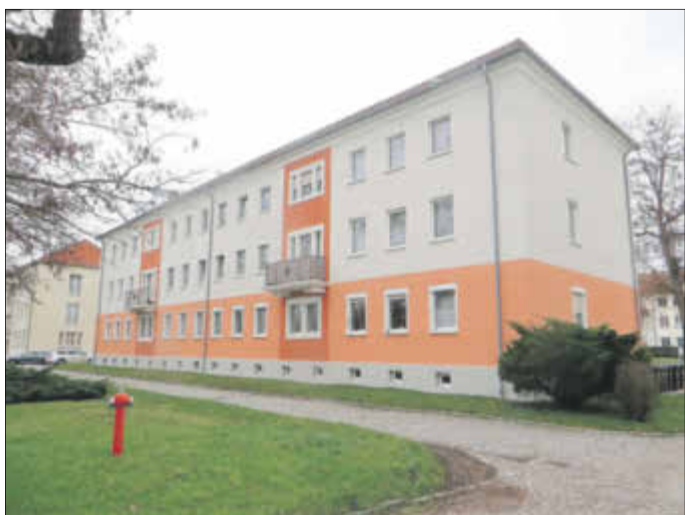
Die Fassadenarbeiten am Gebäude in der Wachenheimer Straße wurden im letzten Jahr abgeschlossen.
