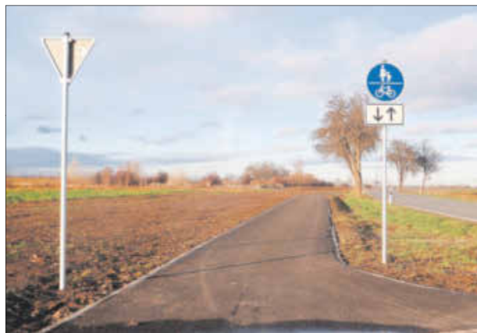
Die Bauarbeiten für den Radweg von Zauschwitz nach Großstorkwitz wurden fertiggestellt und abgenommen.
