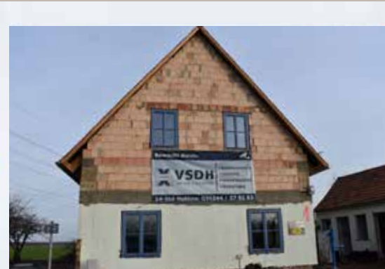
Sanierung Einfamilienhaus im OT Sittel
