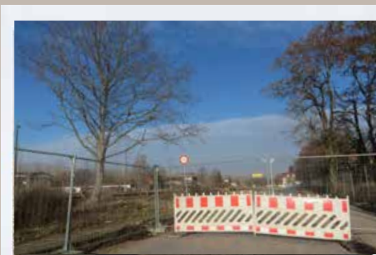
Wachenheimer Straße: Baubeginn Neubau ÖPNV-Verknüpfungsstelle
