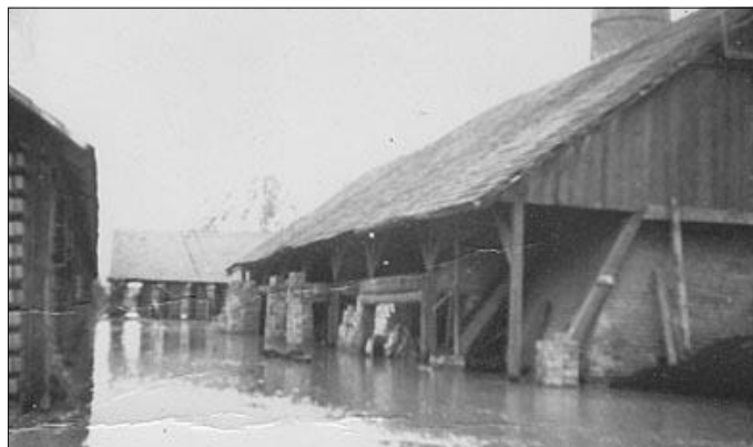
Auch das Gelände der Pegauer Ziegelei Erbs steht komplett im Wasser der Elster. Die Produktion der Steine ist eingestellt.
