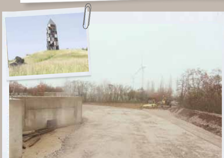
Aussichtsturm Stöntzsch: Aufstellflächen für Arbeitsbühnen und Kran sind hergestellt.
